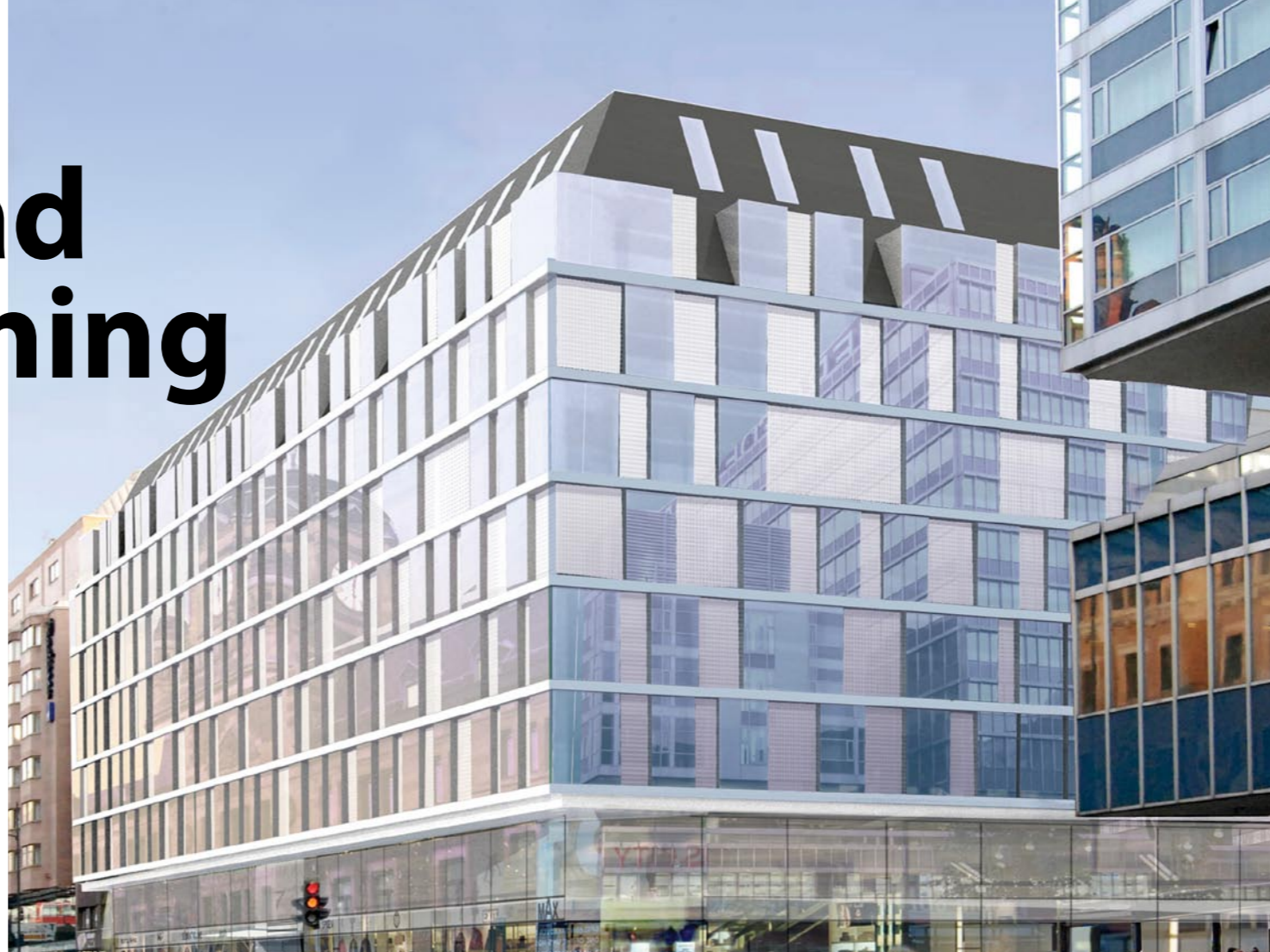
Byggnaden har försetts med effektiva fönster och glasfasader med låga u-värden (max 1,2 W/m 2 , K). Utvändiga solskydd hindrar oönskad solinstrålning och minskar fastighetens kylbehov.
